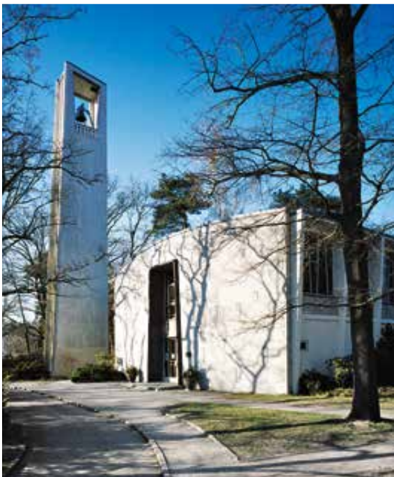
US-Army-Chapel am Hüttenweg in Zehlendorf. Foto: Mila Hacke
